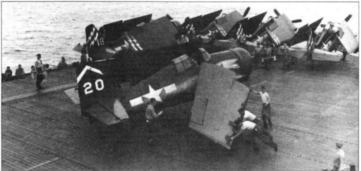
Палубная команда складывает крылья истребителя FM-2 из эскадрильи VC-85, авианосец «Хогзэт Бэй», 2 июля 1945 г. Белый шеврон на вертикальном оперении самолета - знак принадлежности аэроплана к эскадрилье VC-85. На заднем плане - истребители из эскадрильи VC-88 (отличительные знак - двойная молния белого цвета).
