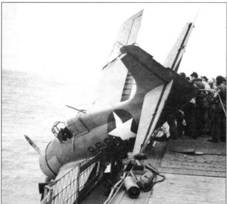
Этот F4F-4 из эскадрильи VF-9 совершил аварийную посадку на палубу «Рэнджера» 25 августа 1942 г. Лишь тормозной гак, захвативший тормозной трос удержал самолет от падения в воду.
