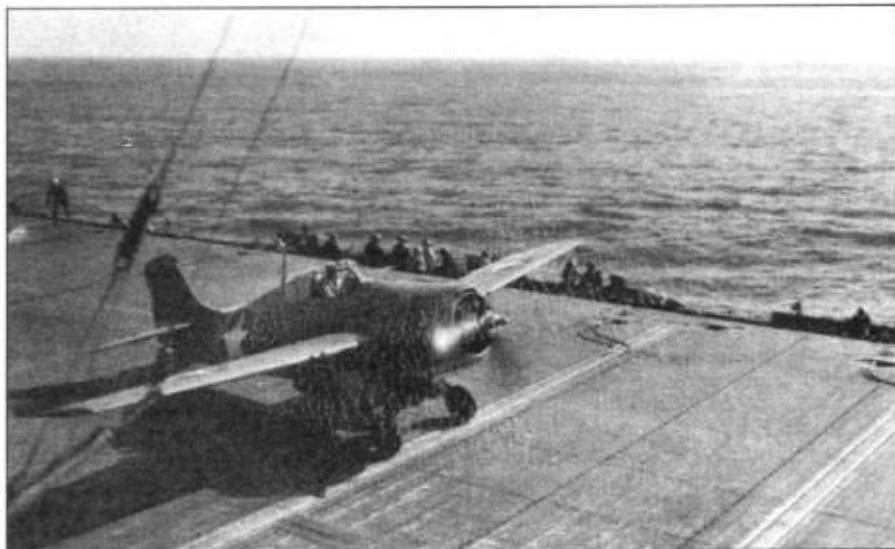
С палубы авианосца «Рэндомер» взлетает F4F, операция «Торч». Под плоскостями крыла самолета подвешены 58-галлоновые топливные баки. В период вторжения в Северную Африку летчикам «Уайлдкэт» пришлось драться с традиционными союзниками - французами; французы летали на истребителях американской постройки Кертисс «Хок-75».
