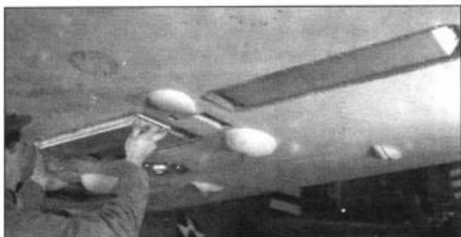
Установка патронных коробок в крыло F4F-4. За ладонью механика виден посадочный прожектор.
