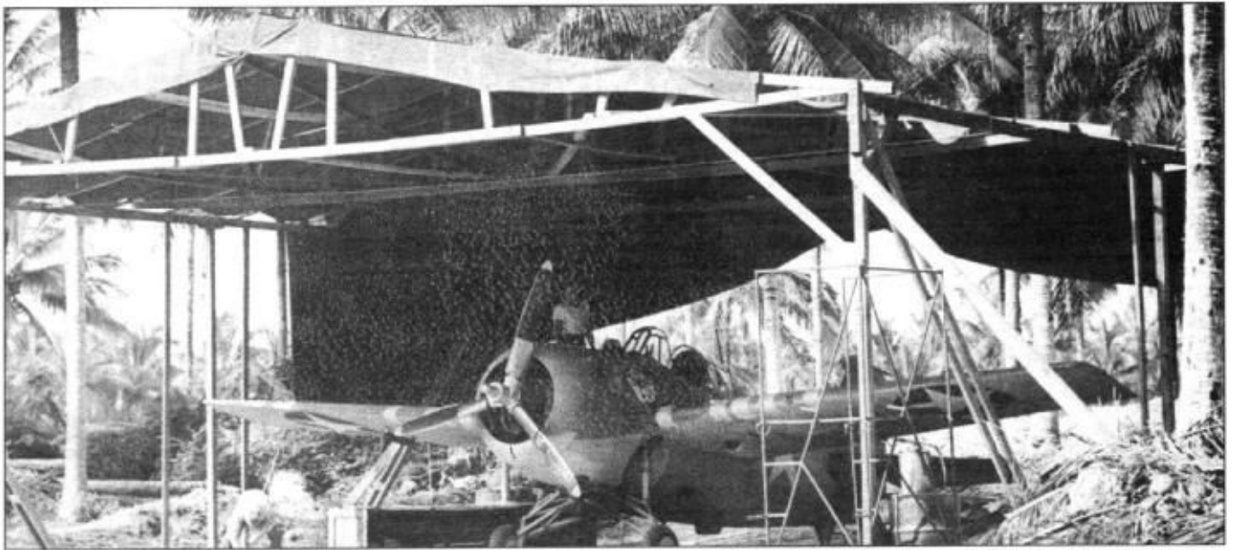
Самодельный ангар служил защитой техническому составу от палящих лучей тропического солнца, Эсперито-Санто. Фоторазведчик F4F-3P принадлежит эскадрильи корпуса морской пехоты США VMO-251. Фотокамера установлена в нижней части фюзеляжа по левому борту.
