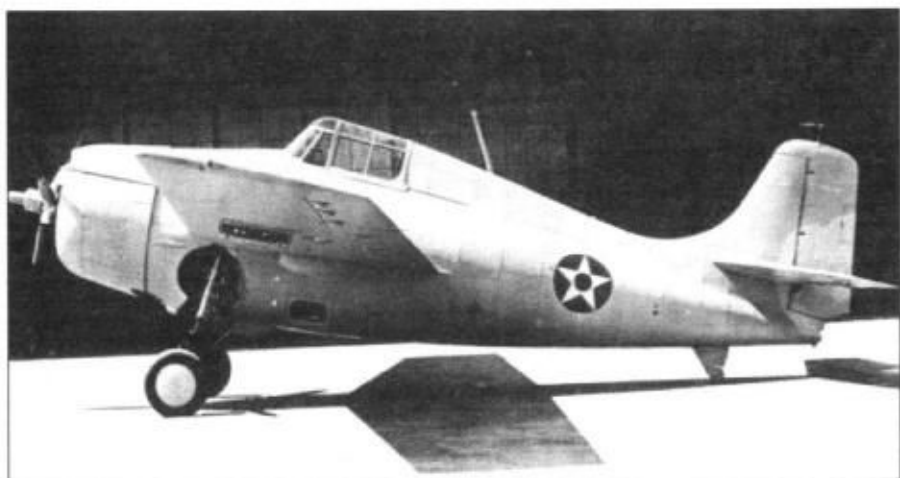
Первый серийный F4F-3A (BuNo 3905) сошел со сборочной линии завода фирмы Грумман 7 апреля 1941 г. На самолеты F4F-3A ставились двигатели Pratt-и-Whitney R-1830-90 мощностью 1200 л.с., в то время как на F4F-3 стояли моторы R-1830-76. Тридцать предназначенных для ВМС США самолетов были переданы согласно заключенному контракту Греции, однако когда Греция капитулировала когда транспорты с самолетами находились еще в море, поэтому они разбурнулись и пошли на Гибралтар.
