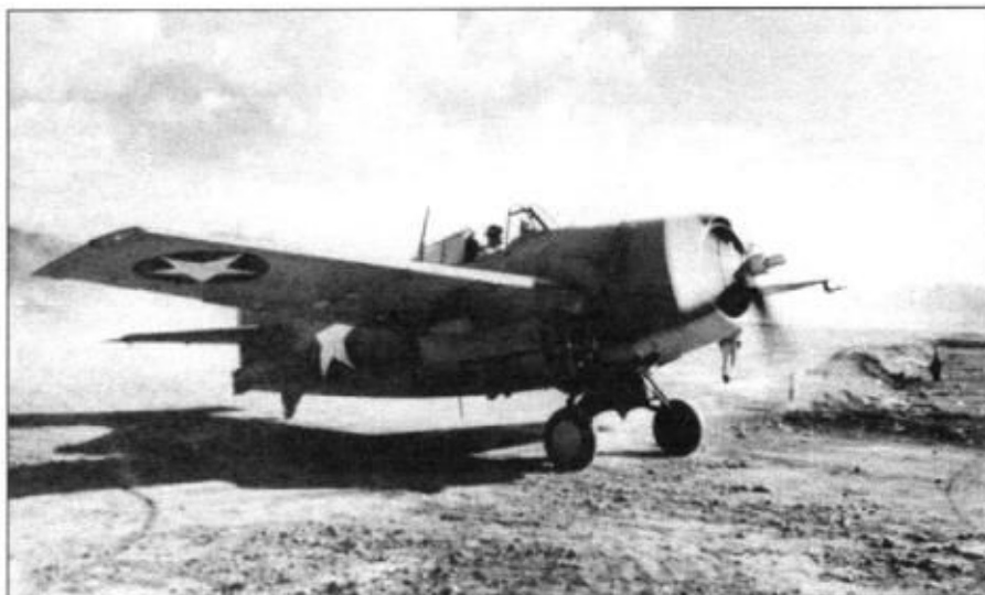
Истребитель F4F-4 корпуса морской пехоты вернулся из боевого вылета, Гуадалканал, декабрь 1942 г. Разбитая коралловая ВПП мало подходила для взлета и посадки палубных истребителей. Пыль забивала фильтры двигателей, камни и осколки кораллов повреждали лопасти воздушных винтов и носки крыльев.
