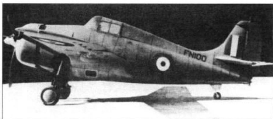
Первый «Мартлет» Mk IV (FN100) сошел со сборочной линии завода фирмы Грумман 27 февраля 1942 г. Самолеты данной модели оснащались моторами Райт R-1820-40B, которые устанавливались под капотами измененной конструкции с узкой щелью для выпуска воздуха по периметру задней кромки.
