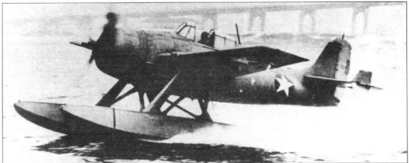
Прототип гидролана F4F-3S «Уайлдкэтфиш» на испытаниях, Норфолк, шт. Вирджиния. Испытания показали что самолет может взлетать и садится при высоте волны до двух футов. Летные характеристики гидролана признали неудовлетворительными, поэтому вопрос о его серийном производстве со стороны заказчика не поднимался.
